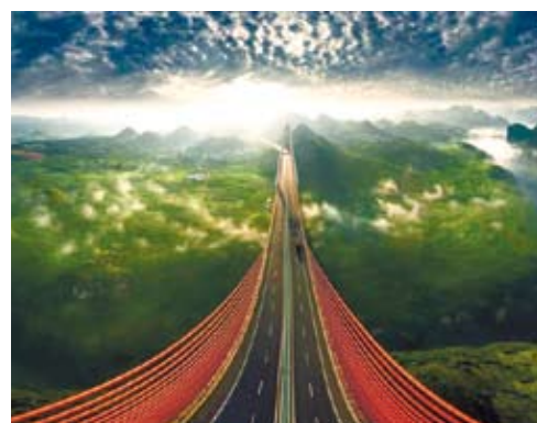
北盤江特大橋
