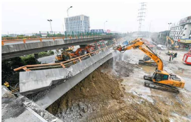
江蘇無錫高架橋側翻事故現場，施工機械在破拆側翻高架橋段。
