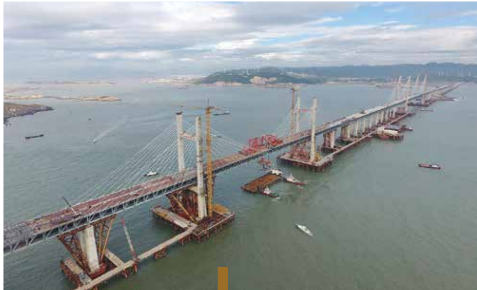
平潭海峽公鐵大橋鼓嶼門航道橋的鋼樑在吊裝中（無人機拍攝）。
